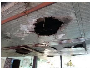
Schäden an den Decken im Essebereich
